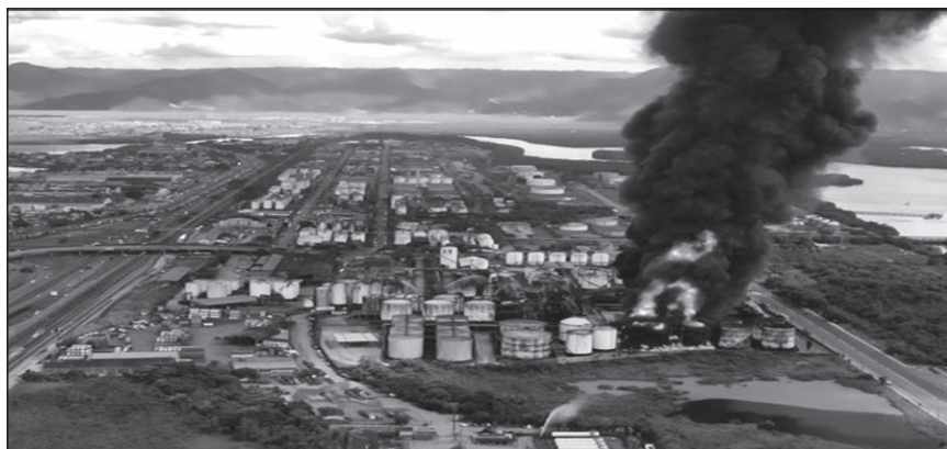
Figura 1 - Incêndio em tanques de combustível - Santos, 2015
