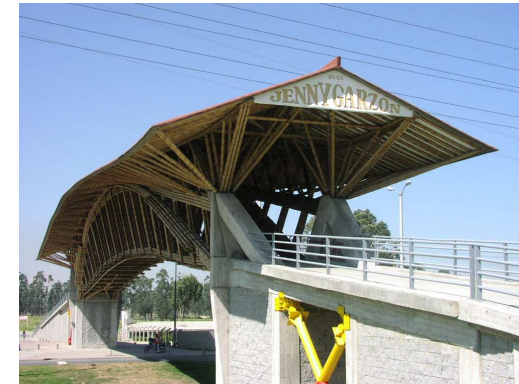
Figura 3: Ponte suspensa de bambu. Fonte: Pereira e Beraldo (2007).
